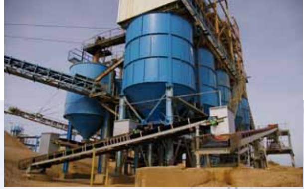
DIE KOMPLETTANLAGE in Dorsfeld, oben Nassaufbereitung, darunter Siloreihen mit Verladestation. Verladen wird über eine ganze Reihe von Bändern.
